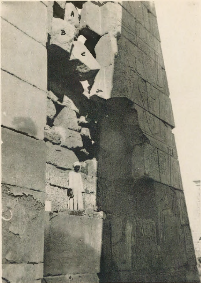
1. — Xe pylône. L'ébrasement Ouest, avant la restauration, janvier 1923.
